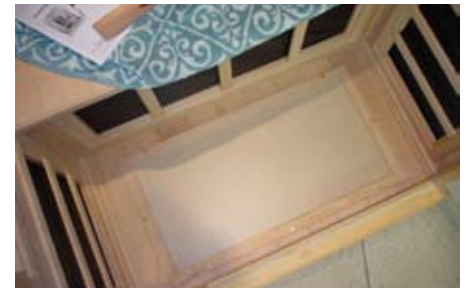
Fußbodenheizung durch Natursteinplatte für mollig warme Füße
